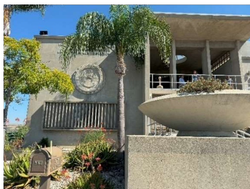
浄水場管理本館入口
