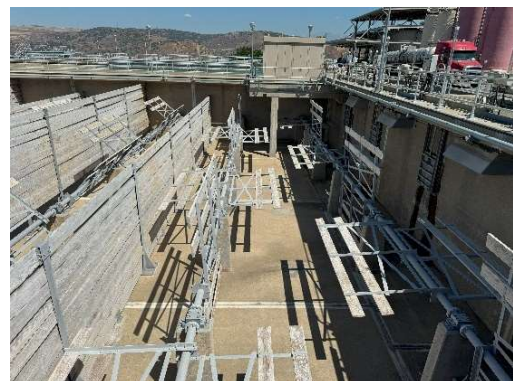
干池中の沈でん池 (フロック形成池)
