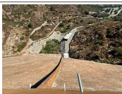
ダム堰堤より下流側を望む
