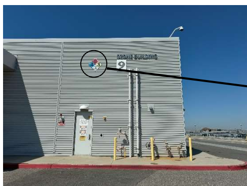
オゾン処理施設入口
