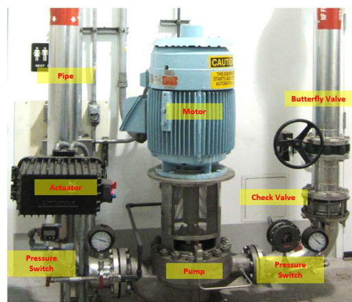
図 11 ポンプ設備の細分化
