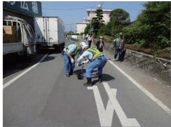
漏水調査作業（バルブ操作）の様子
