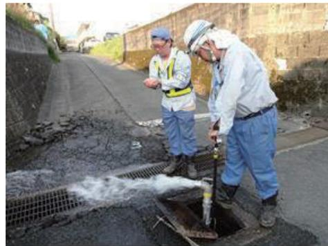
漏水調査作業(管洗浄)の様子
