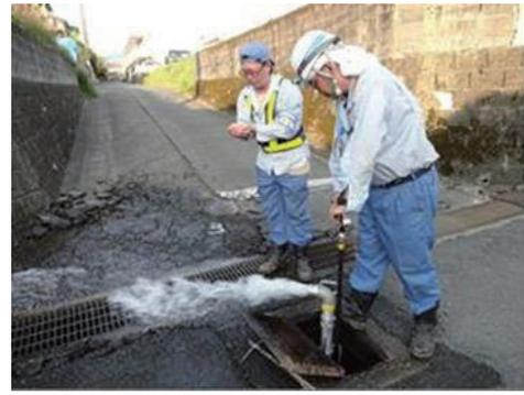
漏水調査作業(管洗浄)の様子
