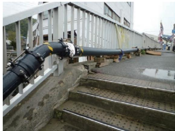
仮設配管(硬質塩化ビニル管)
