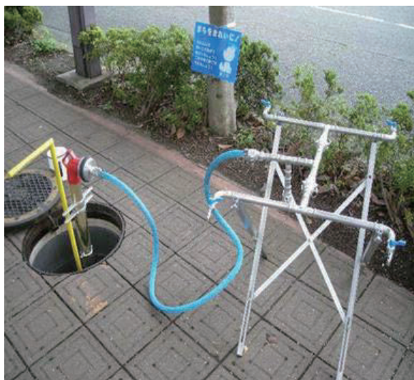
消火栓からの応急給水①
