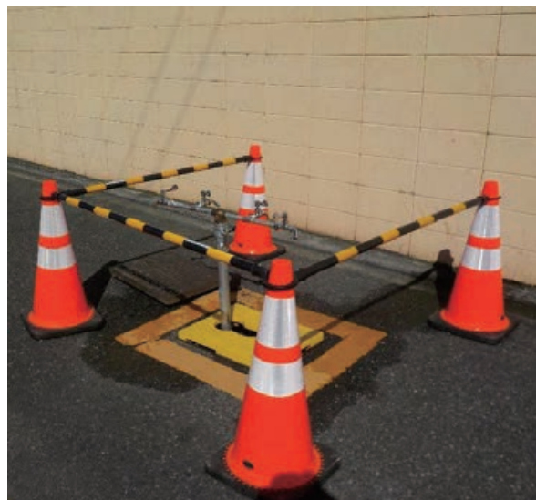
消火栓からの応急給水②
